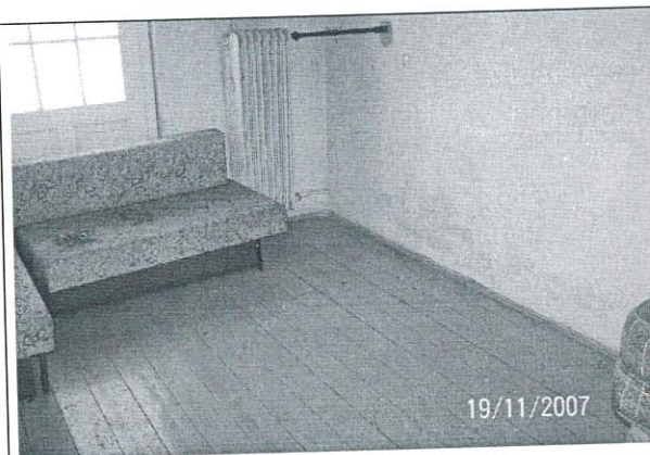
Widok podłogi na poddaszu oraz tynków wewnętrznych - zawilgocenia
