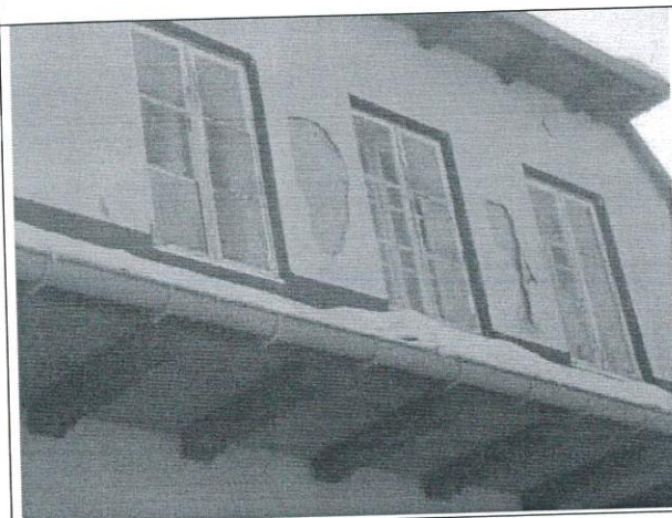
Ubytki tynków zewnętrznych
