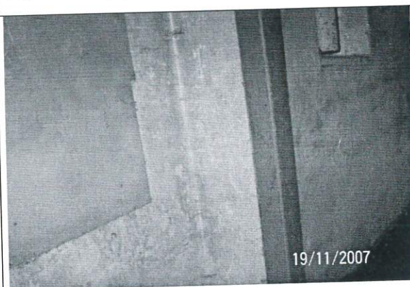
Ubytki oraz spękania tynków zewnętrznych
