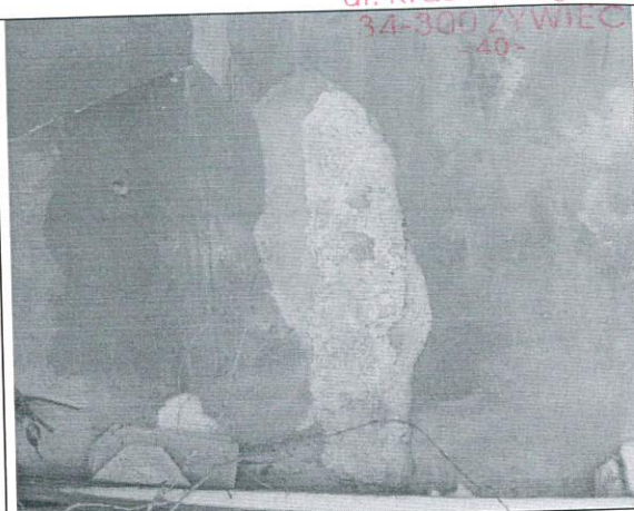
Ubytki oraz spękania tynków zewnętrznych
