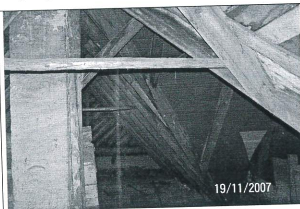
Widok elem. konstr dachu – zalecane wzmocnienie
